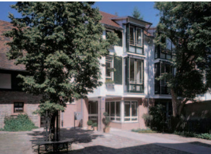
Blick vom Hof aus auf den Eingang ins Hospiz „Arista“
